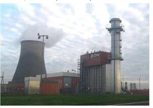
Pour le cycle gaz : les gaz d'échappement en fin de détente des TAC sont à une température élevée (550 – 650 °C) – le travail de compression représente environ 50 % de la puissance produite ; pour ces raisons, le rendement est limité à des valeurs comprises entre 35 et 40 %.
